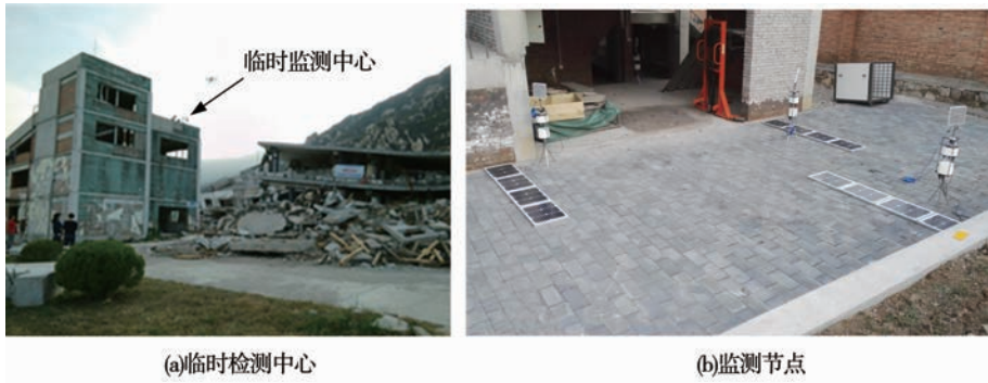
图 4 现场测试照片
